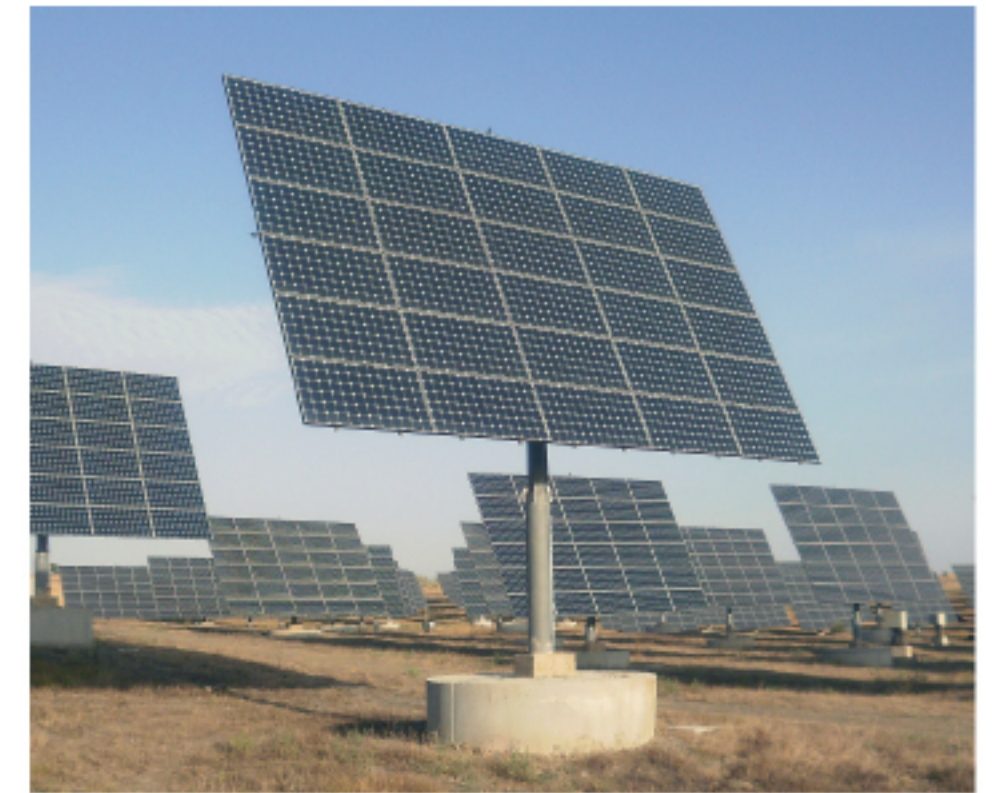
800 kW sobre seguidores en Villanueva del Duque (Córdoba)
