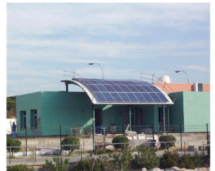
6,12 kW sobre cubierta curvada en el Punto de información del Parque Natural La Breña y Marismas en Barbate (Cádiz)
